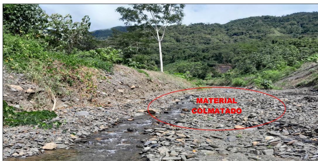
FIGURA N°02: MATERIAL COLMATADO EN EL CAUCE DE LA QDA. TALANCATO, CON UNA PROFUNDIDAD PROMEDIO DE 1.50 M. ESTO PROVOCA SOCAVAMIENTO DE LA QDA. SEA MAS INMINENTE.
